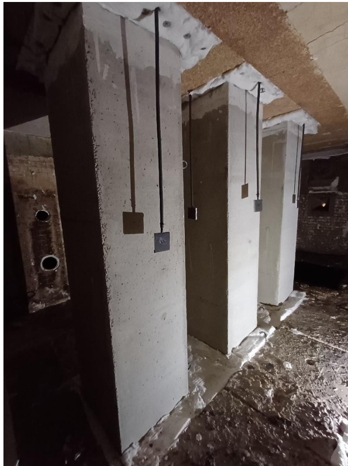
Photos des conduits à l'intérieur du four
