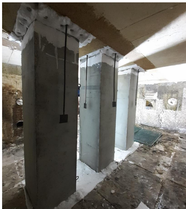
Photos des conduits à l'intérieur du four
